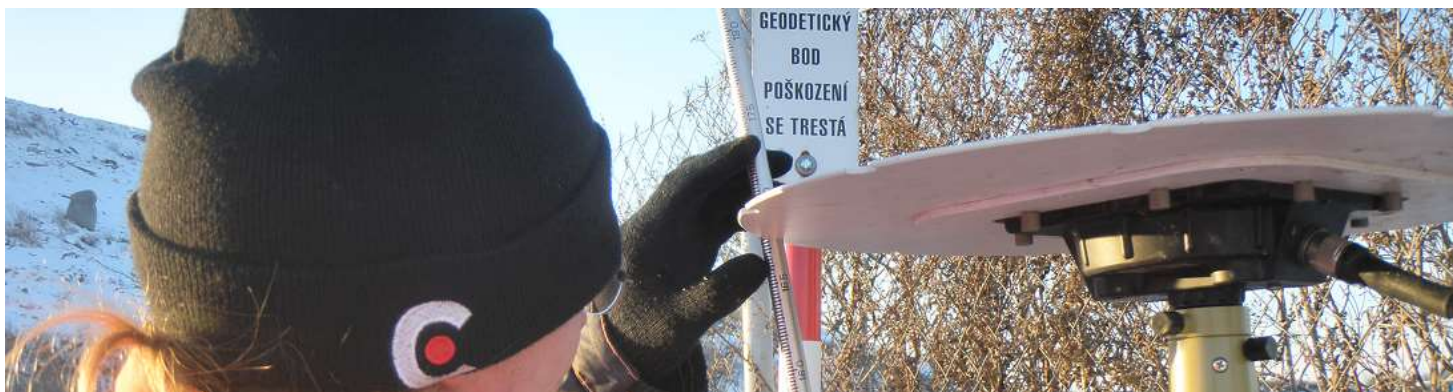
Obr. 2 – Měření je připojené na geodetický bod stavby pomocí referenční stanice GPS
