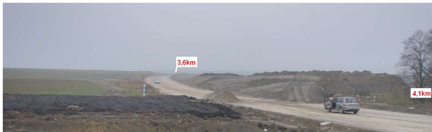
Měření 06S PV, MP 9.11.-10.11.2009.
