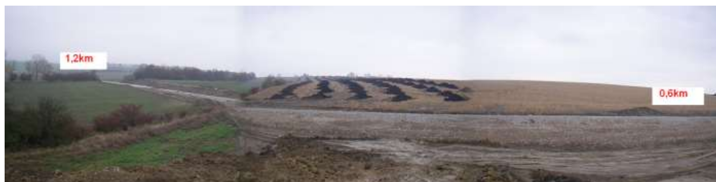
Měření 06S PV, MP 9.11.-10.11.2009.
