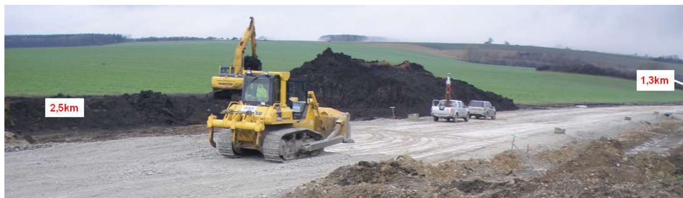
Měření 06S PV, MP 9.11.-10.11.2009.
