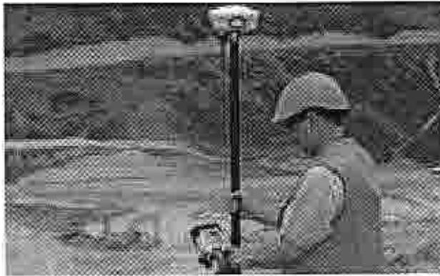
Obrázek 16 - měření systémem GPS
