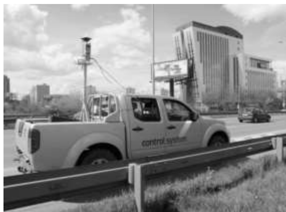
Obrázek 1: 3D TLS – technologie přesného měření povrchu vozovky
