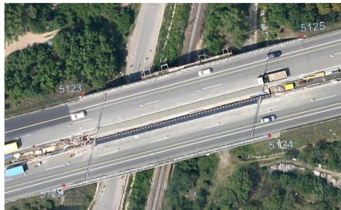
Obrázek 1: Přehledka mostu s body vytyčovací sítě
