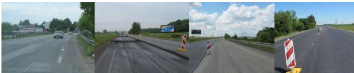
Obr. 3: Rekonstrukce vozovky (zdroj: Control System)
