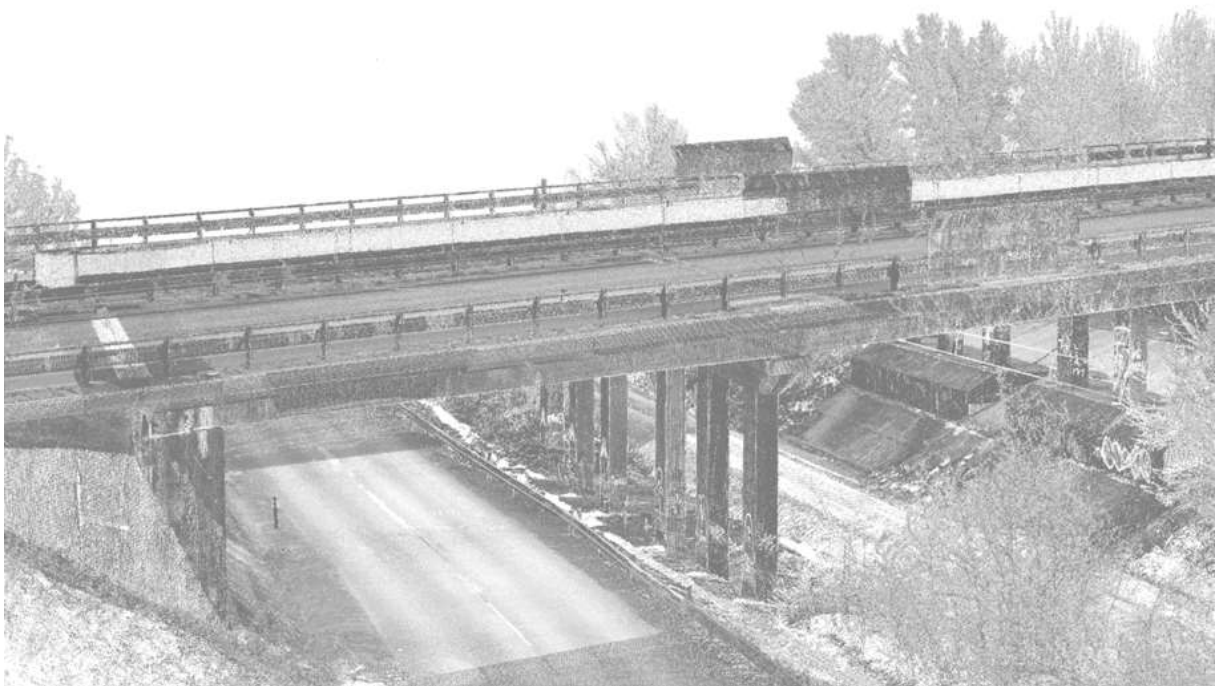
Obr. 5: Mračno bodů laserové skenování (zdroj: Control System)
