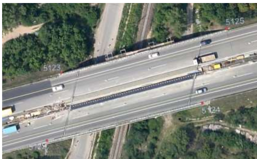
Obr. 2: Přehledka mostu s body vytyčovací sítě (zdroj: Control System)
